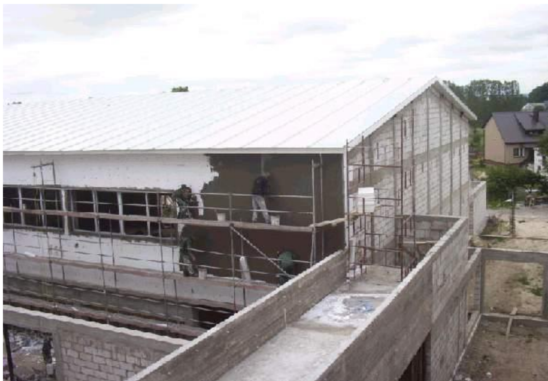
Budowa hali sportowej
